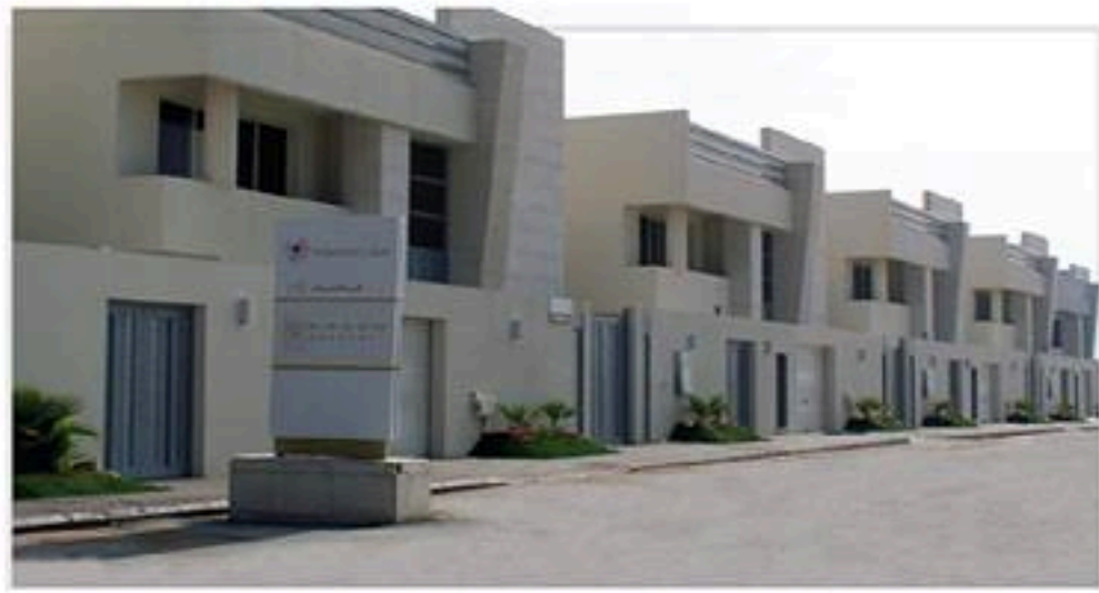
مجتمع سكني Compound
